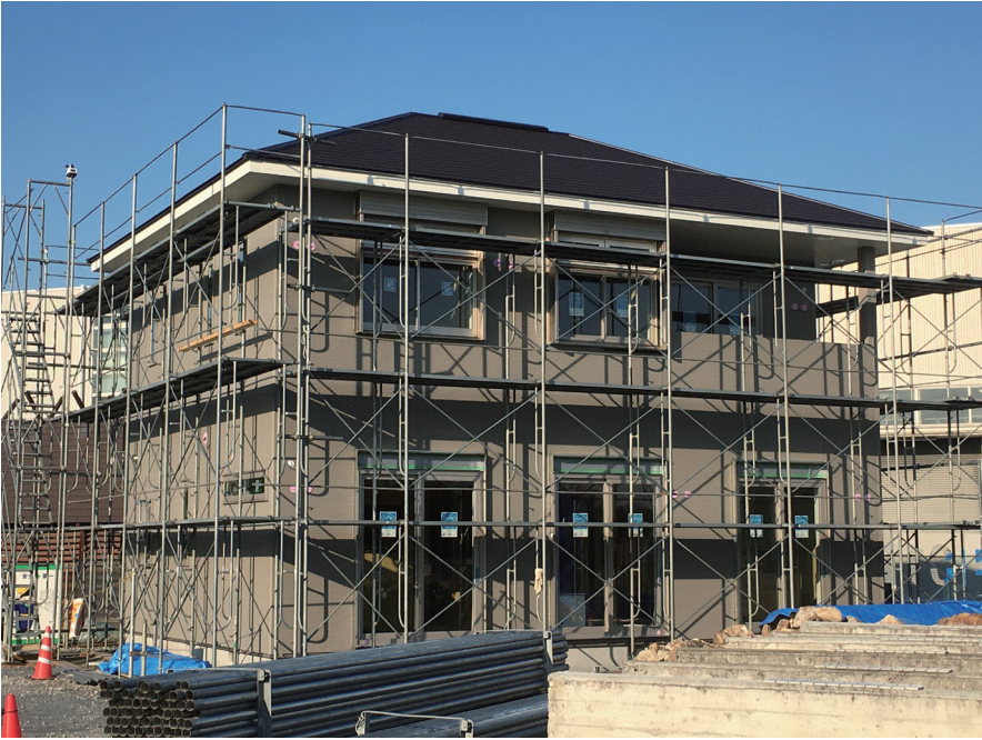
ものづくり大学敷地内に建設中の実験住宅。部分気密など、さまざまな気密についてのデータを集める
